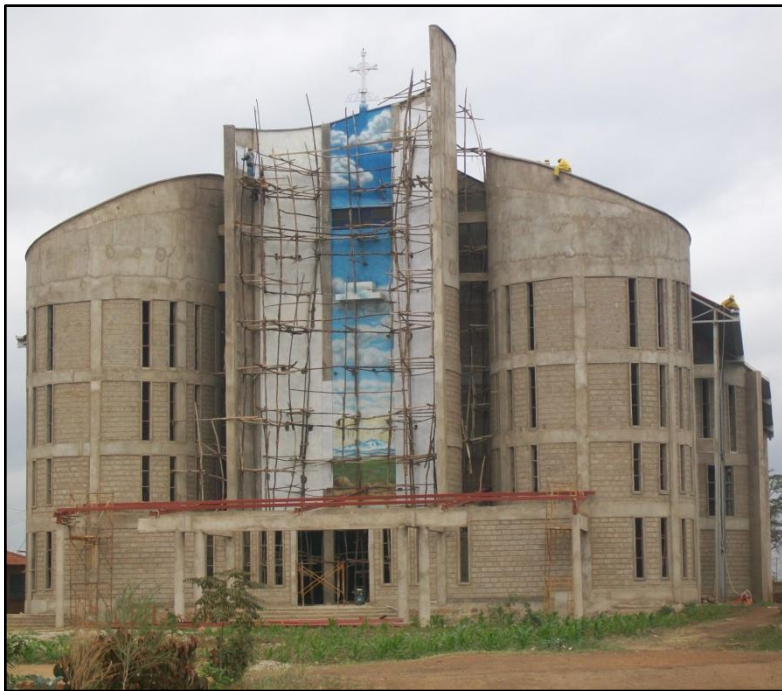
Iglesia en construcción, Parroquia Santa Mónica (Nairobi)
