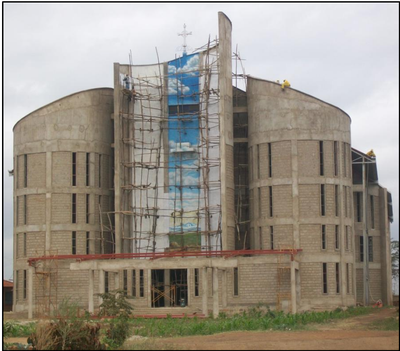
Eglise en construction Paroisse Ste Monique (Nairobi)
