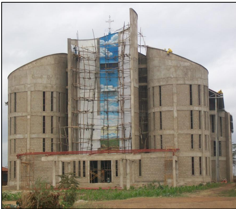
Iglesia en construcción, Parroquia Santa Mónica (Nairobi)
